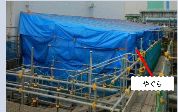
配管ピット外観
