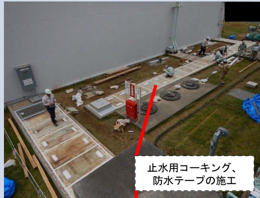
配管ピット外観
